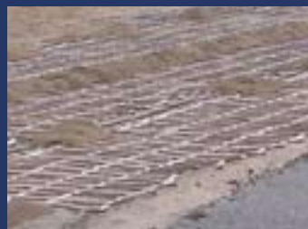
Jyrkät ajoluiskat aiheuttavat jäätyessään vaaratilanteita, joita estät asentamalla luiskan asfalttiin alle lämmityskaapelin.
