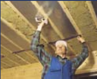
Elementin asennus onnistuu yhdeltä mieheltä helposti. Samalla kun elementtirullaa avataan, se kiinnitetään esim. nitomalla kattorimoihin, tiiviisti lämpöeristettä vasten. Pintamateriaaleissa on vain vähän rajoituksia.
